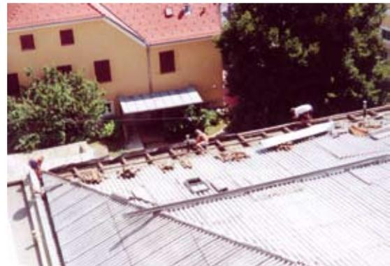
gedämmt war, wurde eine 20 cm dicke Wärmedämmung aufgebracht. Längerfristig wird der ATG mit dieser Dachsanierung erheblich an Energiekosten sparen.
