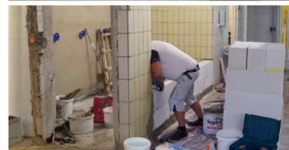
Die Duschanlage wurde erneuert, es wurde ein neuer seitlicher Zugang geschaffen, direkt über den Duschen wurde eine Abluftanlage installiert und die Vorderseite des Duschaums wurde geschlossen. Wir erwarten damit eine geringere Feuchtigkeitsbelastung von den Duschen im Schwimmbeckenbereich. Die WC-Anlagen bekamen eine neue Bodenverfließung. Weiters wurden im gesamten Becken und rund ums Pool alle Wartungsfugen mit Schwimm-
